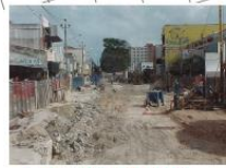
AV. TRISTÃO GONÇALVES COM FRENTO PEREIRA, OBRAS METROPOL-VISADA NORTE
