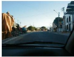
AV. CABARINHA TERCEIRO EM OBRAS METROPOL- VISADA SUL
