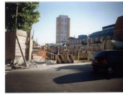
CRUZAMENTO AV. CABARINHA COM JOSÉ GALVÃO - OBRAS METROPOL
