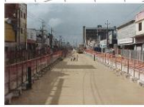
AV. TRISTÃO GONÇALVES COM FRENTO PEREIRA, OBRAS METROPOL-VISADA SUL
